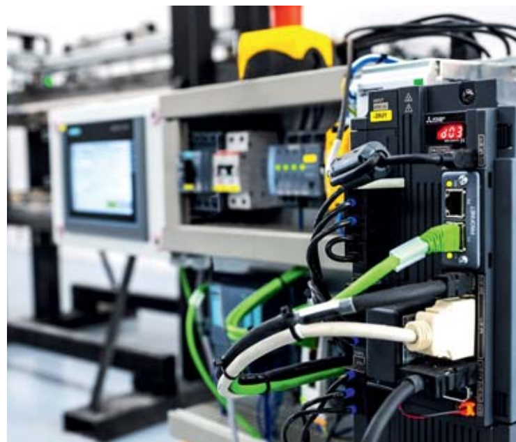
Für die schnelle Inbetriebnahme des Melservo-Antriebsreglers kam das Engineering-Werkzeug ‚Motorizer‘ zum Einsatz.
